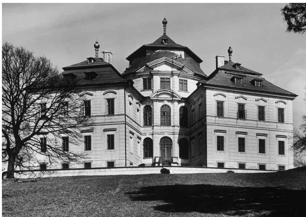
Chlumec nad Cidlinou, zámek Karlova Koruna, exteriér, celkový pohled
